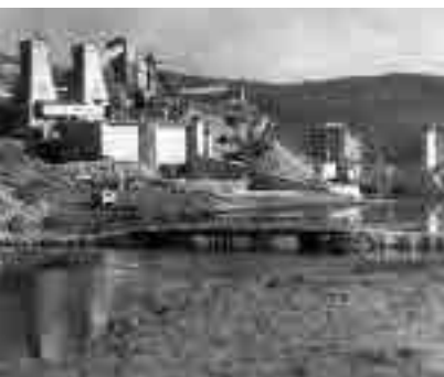
Errichtung des Staudamms Lipno I (1952–1959)
